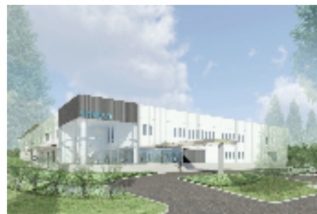
【新工場建物外観イメージ】
